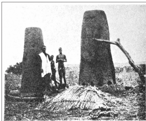
Ryc. 5. Piece typu Banyeri/Bandjeli, Togo, Afryka Zachodnia (za F. von Luschanem: 1909, s. 39, ryc. 17) (oprac. P. Madera)
