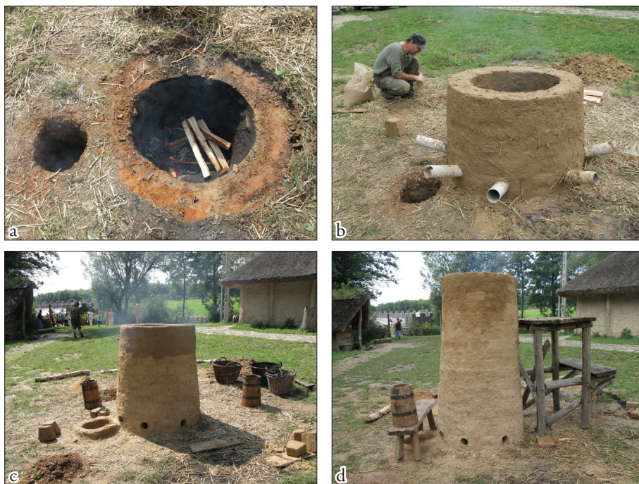
Ryc. 7. Etapy budowy pieca doświadczalnego („Dymarki Świętokrzyskie” w 2014 r.) (fot. P. Madera); a – przygotowanie kotlinki i kanału kotlinkowego; b – formowanie otworów dmuchowych; c – wznoszenie szybu; d – wznoszenie górnych partii szybu z wykorzystaniem drewnianej platformy
