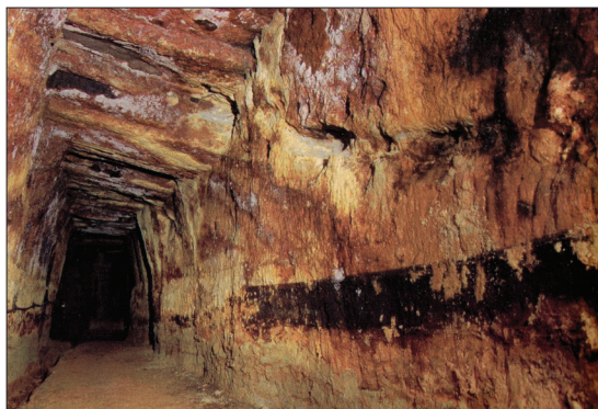
Ryc. 2. Rzymskie galerie górnicze w formie trapezowej w masywie Orlea (Roşia Montană) w Rumunii (wg V. Rus 2012, s. 46)
