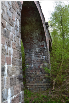
Wiadukt na trasie Polanów-Korzybie (Fot. M. Pawleta).
