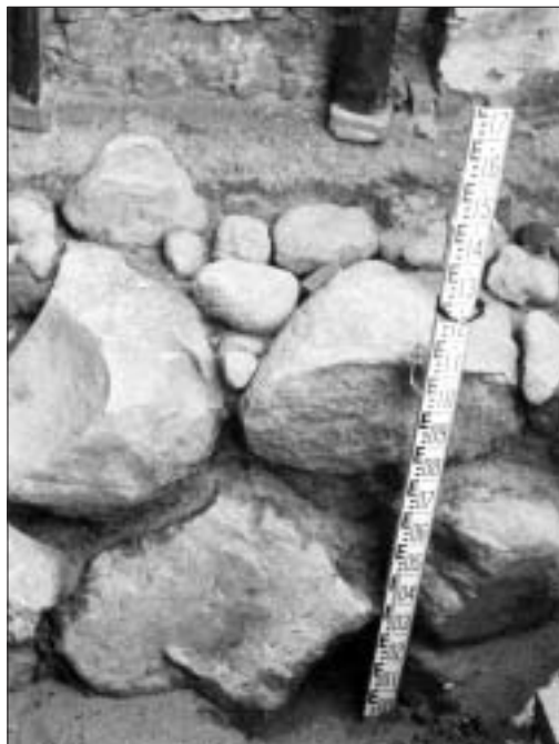
Ryc. 6. Fundament ściany południowej kościoła. Fot. B. Stolpiak.
