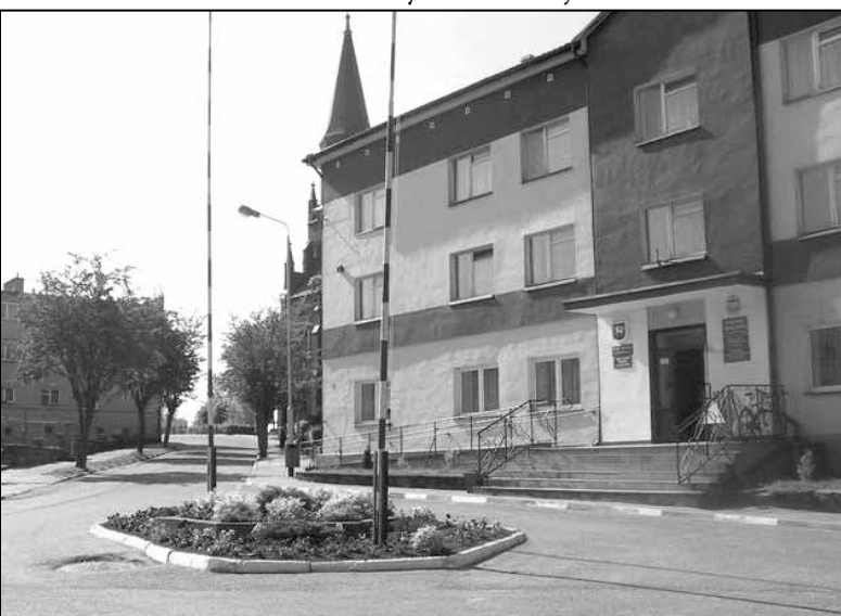
Siedziba (od 02.08.1958 roku) Miejskiej Rady Narodowej przy ul. Ratuszowej, przed modernizacją.
