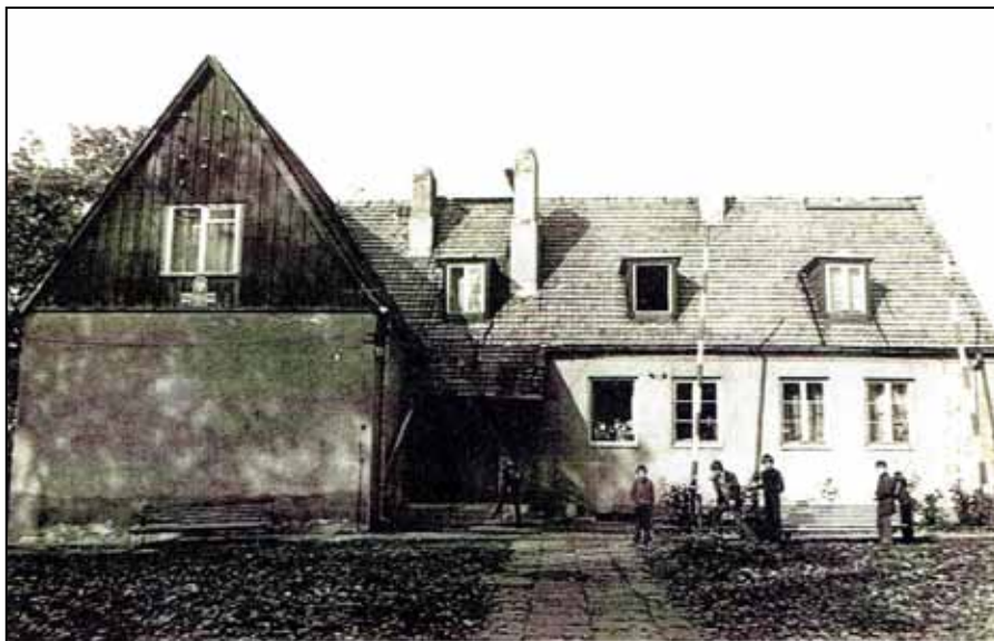
Budynek dawnej szkoły
